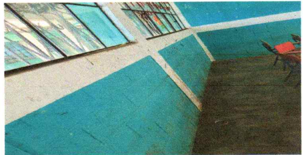
Foto 12: Pintura del edificio escolar parte interior
