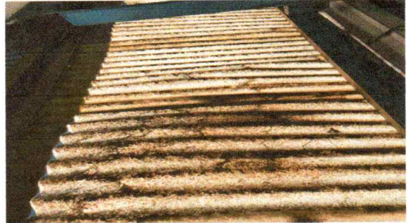
Foto 8: Sustitución de lámina en corredores del edificio escolar
