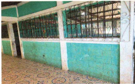
Foto 11 : Pintura del edificio escolar parte exterior
